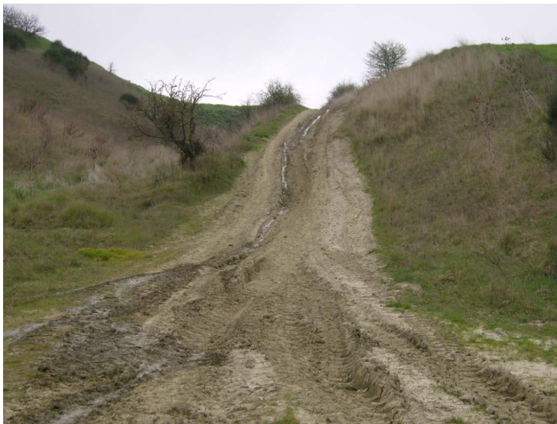
Figura 14: Vista della strada che consente di raggiungere le particelle 1 e 48.
